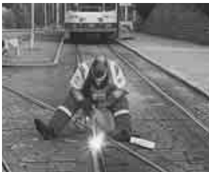
Reparation av spårvagnsräl: OK 67.52.
