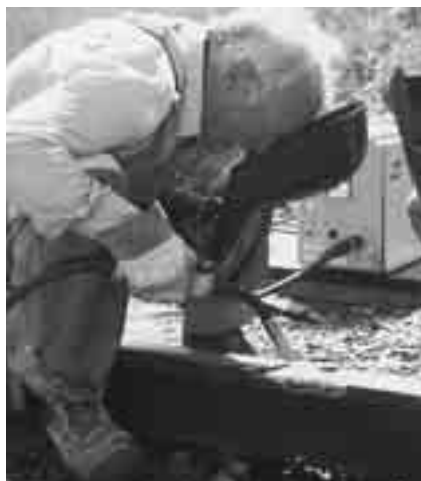
Reparation av slirspår: OK Tubrodur 15.43.
