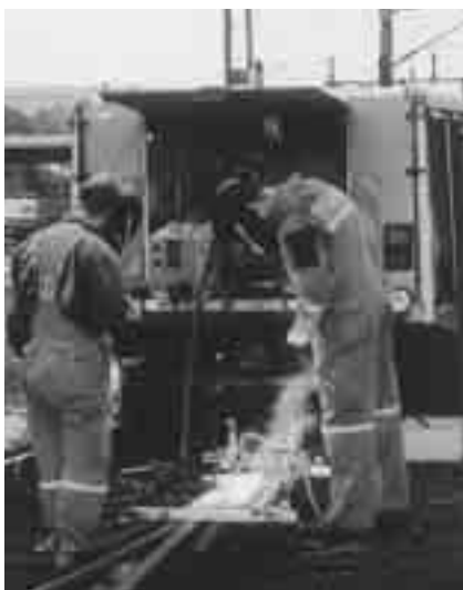
Mekaniserad svetsning: Railtrac BV/OK Tubrodur 15.43.
