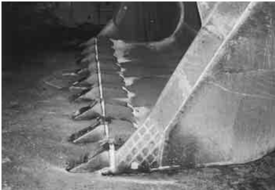
Förebyggande hårdsvetsning med OK 84.58.
